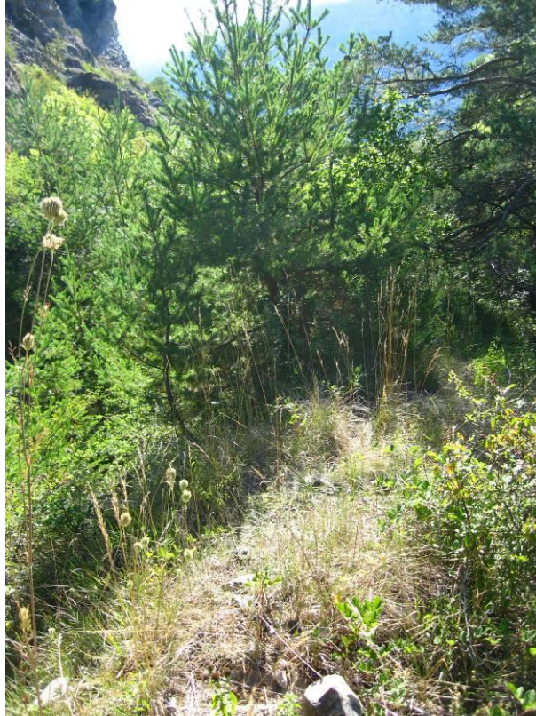
Vue extrémité ouest du merlon de protection à Sous la Roche
