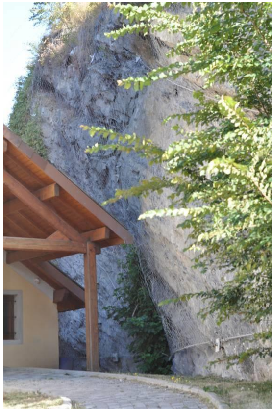
Filet de protection plaquée contre la paroi rocheuse derrière la maison de Pays à Sous-la-Roche
