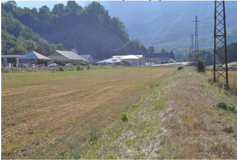
Vue de la digue constituée par la conduite forcée à Sous-la-Route
