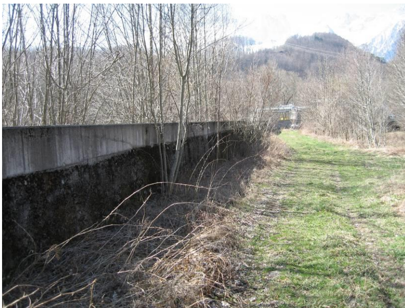
Muret de protection en bordure de la zone de projet d'une nouvelle zone d'activité – ouvrage qui semble en bon état – même hauteur que le talus naturel bordant la Séveraisse
