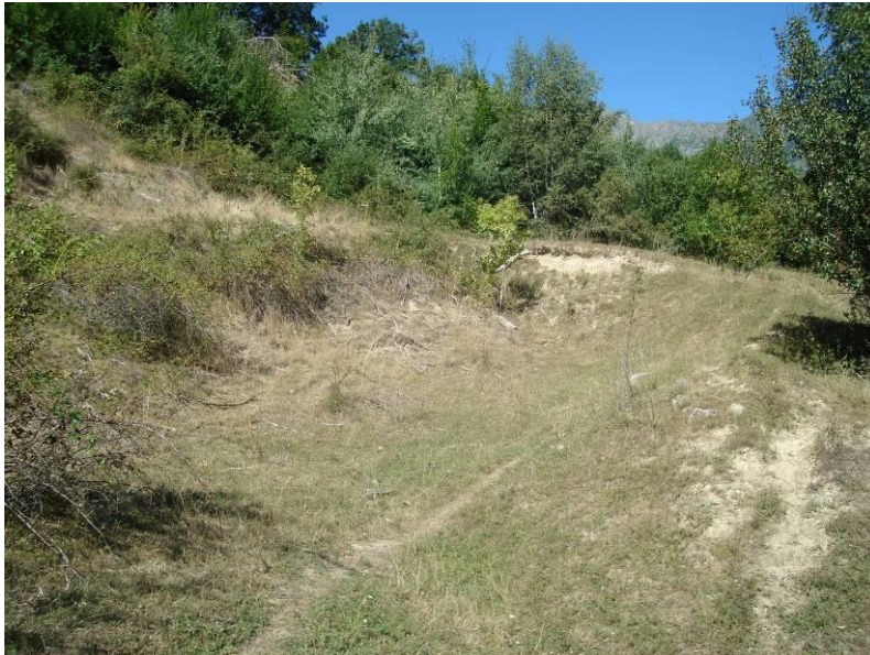
Près au-dessus du talus amont de la RD985 à 150m de la Maison de Pays. Surface très déformée en cuvette
