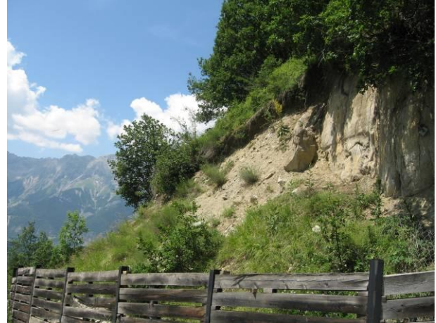
Filet pare blocs et protection contre le glissement du talus par des panneaux en bois sur la route menant au Villard
