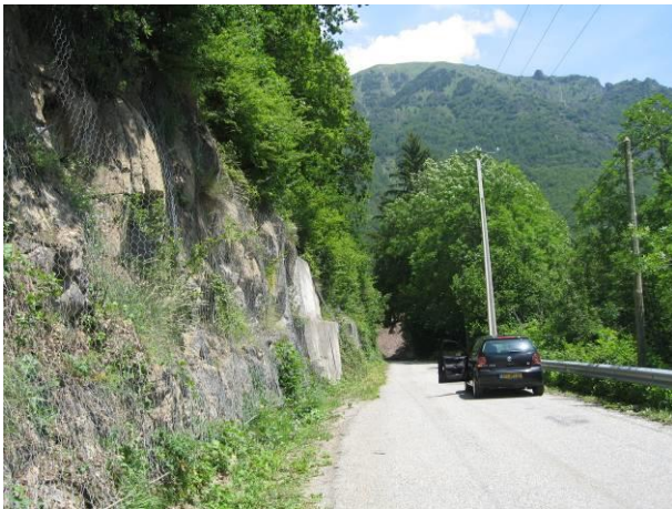
Filet pare blocs et protection contre le glissement du talus par des panneaux en bois sur la route menant au Villard
