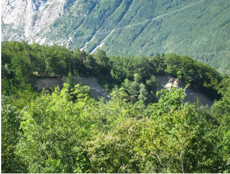
Zone de glissement en rive gauche du Brudour, en amont du Motty vue du versant opposé
