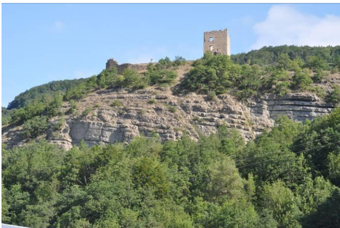
Falaise sous le Fort à Sous-la-Roche
