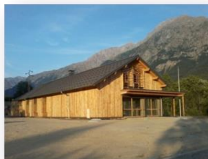
Maison de santé pluridisciplinaire de Saint-Firmin
