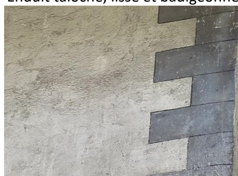
Enduit taloché, lissé et badigeonné
