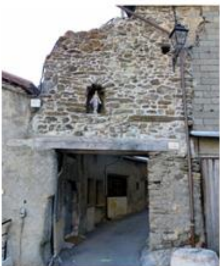
Arcade, rue de l'Arche
