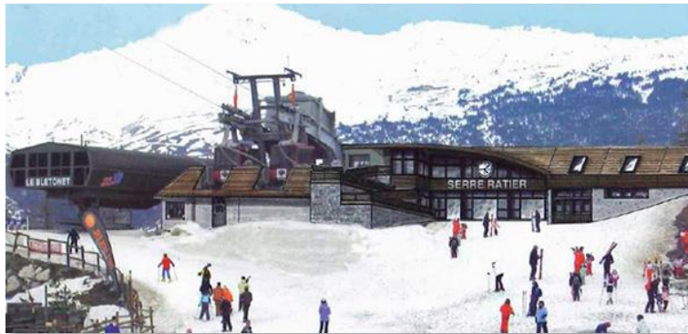
Gare intermédiaire de la télécabine de Ratier Source : Blog de Serre Chevalier Vallée [en ligne]
