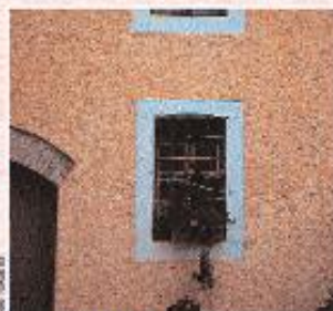
Rehabilitation de façade
