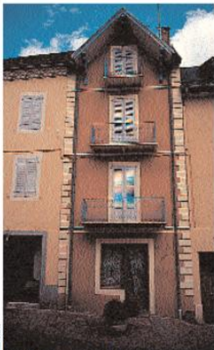
Saint-Bonnet, enduits colorés et décors de façades (encadrement de fenêtre, chaînages d'angle...)
