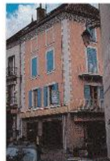
Traitement de façade en angle de rue
