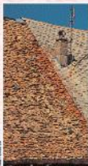
Toitures à Ancelle
