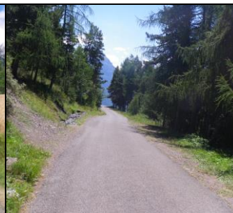
La RD 509t, une route dédiée à la desserte du Lac de Saint-Apollinaire (voie étroite)
