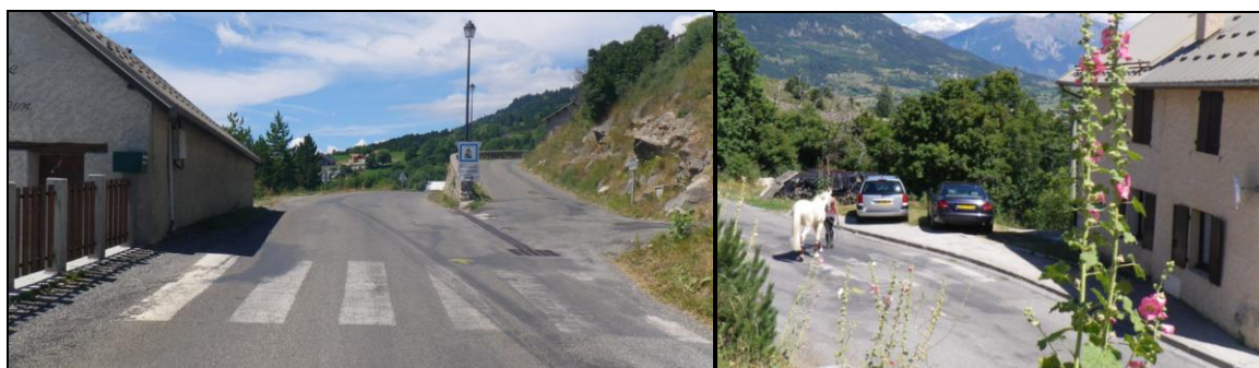
Des traversées piétonnes effacées et des trottoirs peu fréquents (photo de droite : une petite portion de trottoir à l'entrée Sud-Ouest du village)
