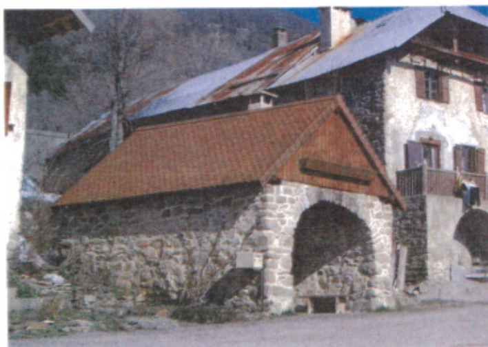
Four à Pain Eglise
