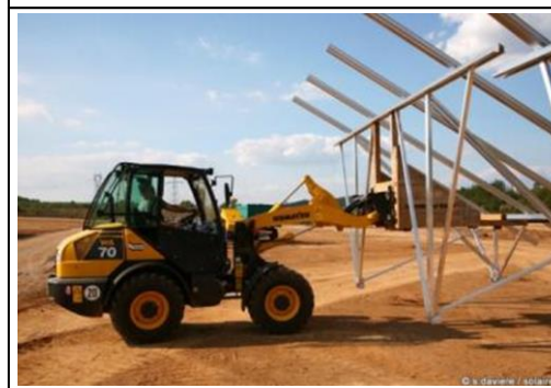
PHASE CONSTRUCTION SUR LE SITE DE VINON
