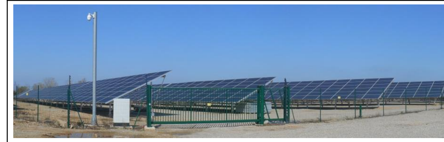
Système de sécurité mixte : caméras sur mâts
