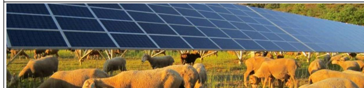
MIXITE D'USAGES POSSIBLE – EXEMPLE DU PARC SOLAIRE DE VINON SUR VERDON
