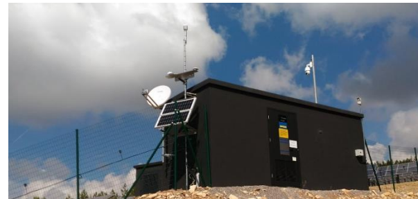
Exemple de Poste de livraison
