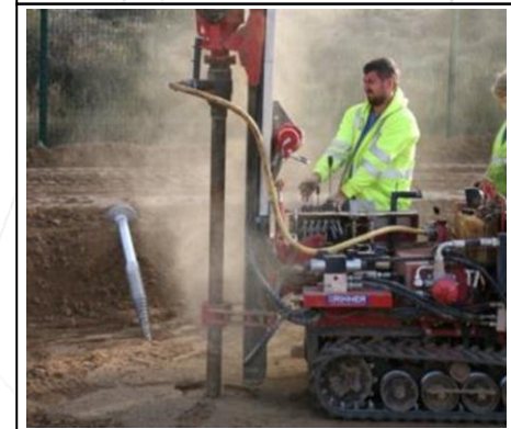
MISE EN PLACE DES VIS
