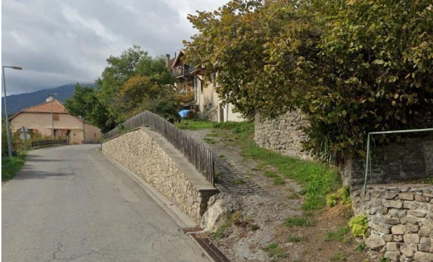
3. Constructions en amont de la RD 446 au village
