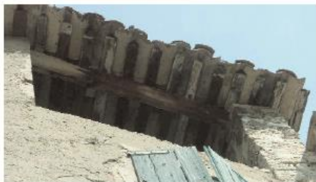
Passée de toiture en tuiles canal sur chevrons triangulaires (quartons) à Orpierre
