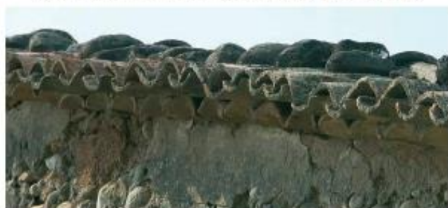
Génoise à un rang en façade pignon (Upxax)
