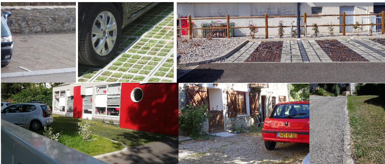
Exemple d'emploi de revêtements perméables pour tout ou partie des aires de circulation et de stationnement.
