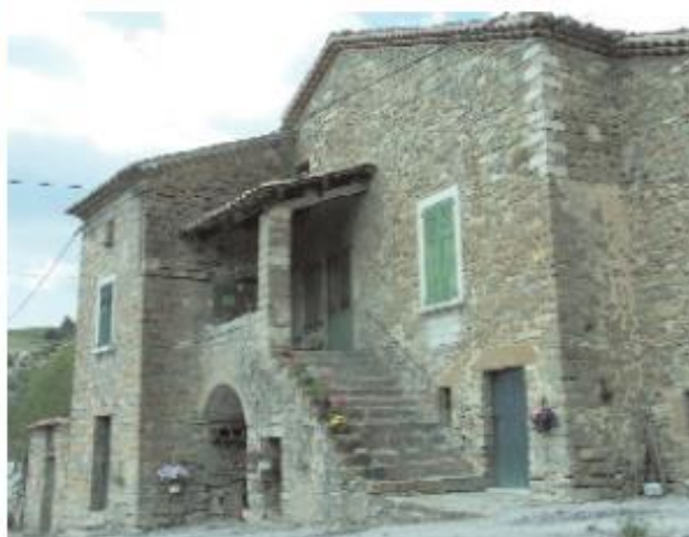
Éléments particuliers d'architecture en façade principale (Ribeyres)
