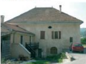
Gros volume de ferme avec toiture à quatre versants dans la vallée de Barcelonnette (influence gapençaise)
