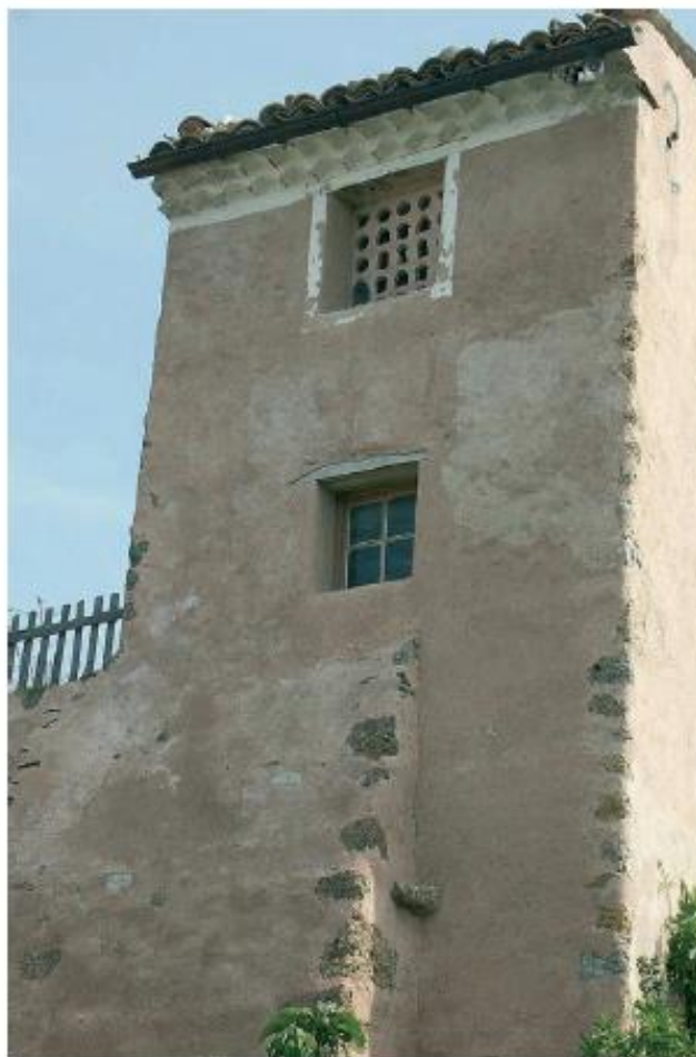
Restauration d'un pigeonnier à Upxaix avec ravalement de façades à l'enduit de plâtre local fabriqué à l'ancienne (2001) (Association de Valorisation du gypse et du plâtre dans les Alpes du Sud)
