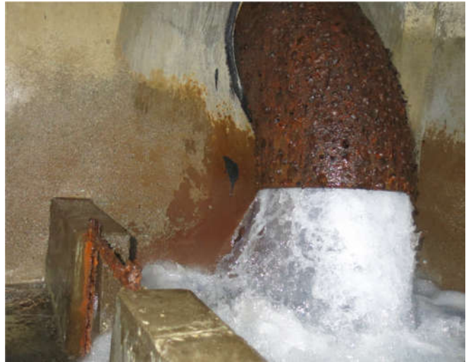
Détail des équipements - corrosion avancée
