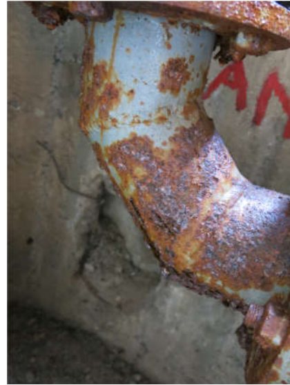
Vue de la fontainerie intérieure : état de corrosion avancé
