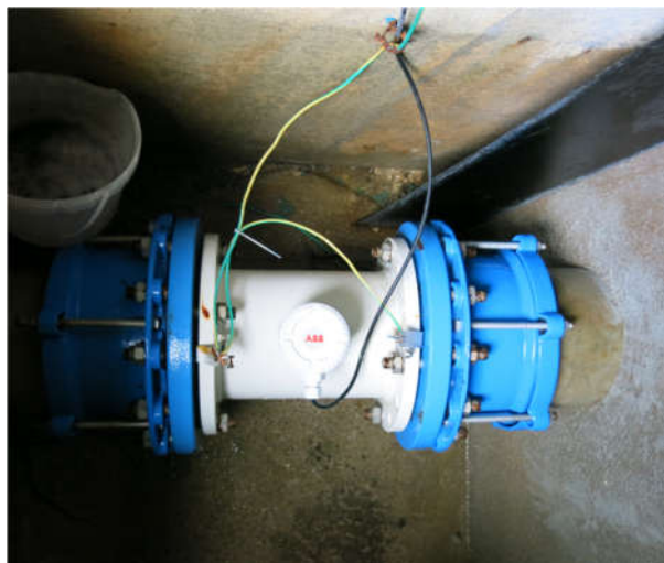
Détail du débitmètre au départ de la conduite (DN200)
