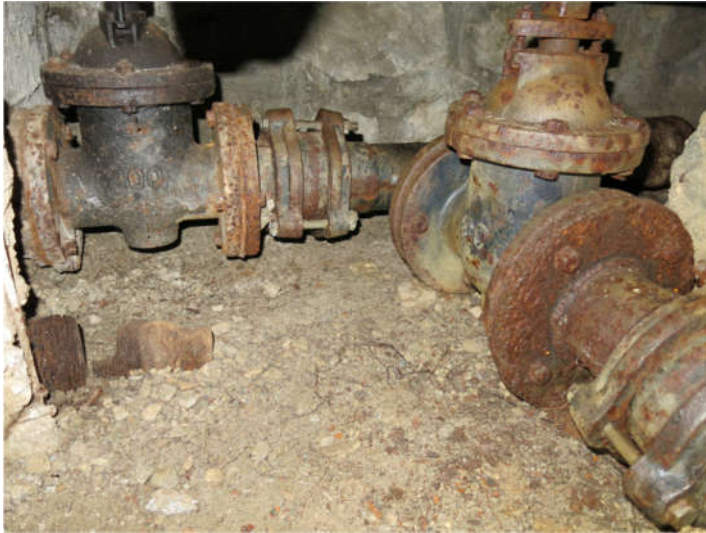
Vue de la fontainerie intérieure : état de corrosion avancé
