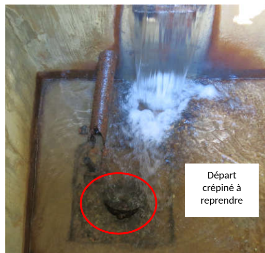
Détail du bac de mise en charge
