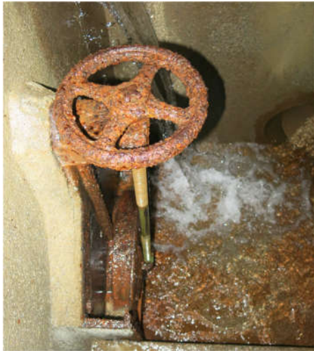
Détail des équipements - corrosion avancée
