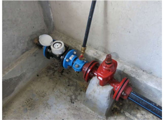
Vue de la chambre de vannes du réservoir
