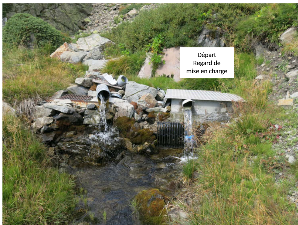
Vue extérieure de l'ouvrage de captage
