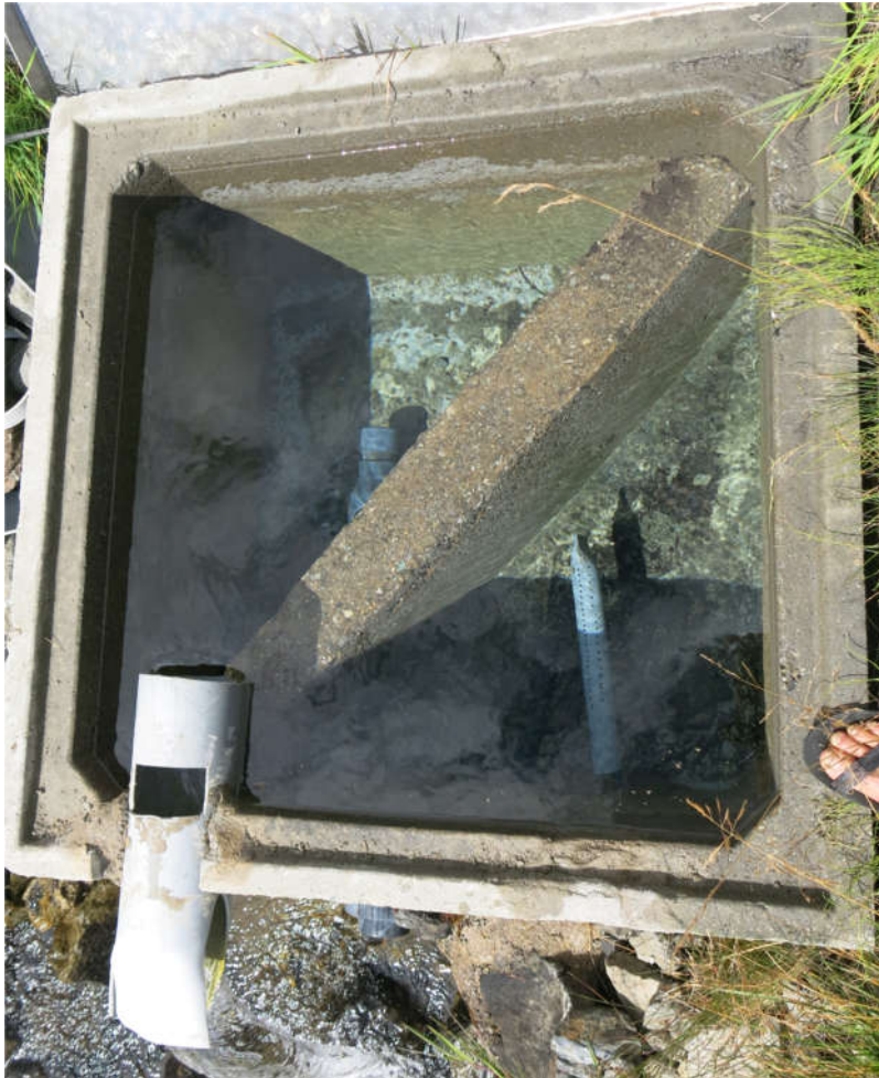
Vue intérieure du regard de captage
