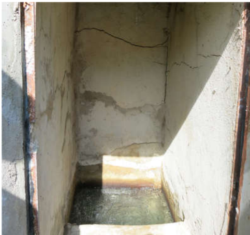
Vue du génie civil intérieur du brise-charge n°1
