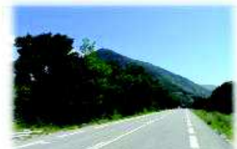
PHOTO 32 - LA RD 994 AU SUD DU PÉRIMÈTRE IMMÉDIAT
