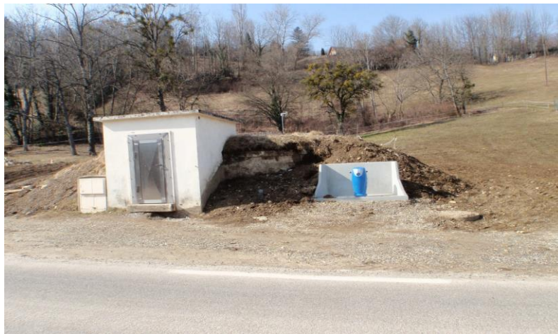
Aménagement de réservoirs artificiels
