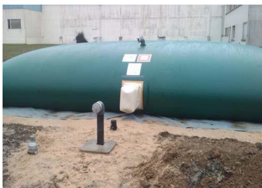
Réserve d'eau souple de 120 m 3 utilisable par le biais d'un poteau d'aspiration
