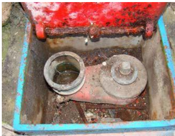
Bouche Incendie de 80 mm à raccord Keyser
