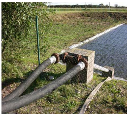
Deux sorties de 100 mm sur une colonne de 150 mm
