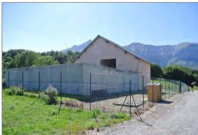
la station d'épuration de Laye
