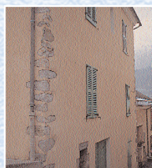
Réhabilitation de façade
