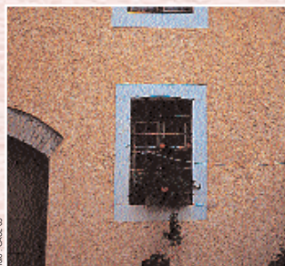
Réhabilitation de façade
