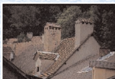
Toitures à Saint-Firmin
