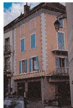
Traitement de façade en angle de rue
