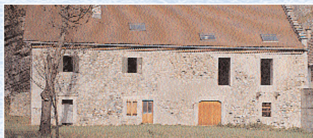
Réhabilitation d'un bâtiment ancien à Saint-Firmin
