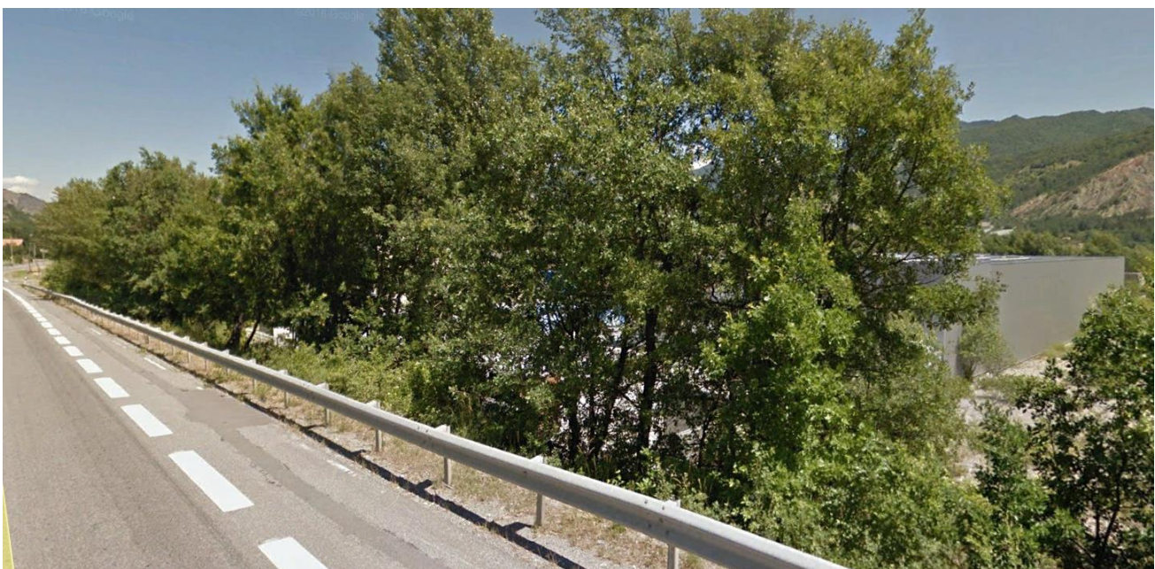
Séquence 5 (en direction de Sisteron – A hauteur de l'actuelle zone d'activités – à droite). En vues rapprochées, la perception des constructions est plus forte qu'en vues lointaines. Le cordon boisé qui borde la RD 1085 et masque les constructions et installations artisanales/industrielles, en léger contrebas, n'est pas continu.
