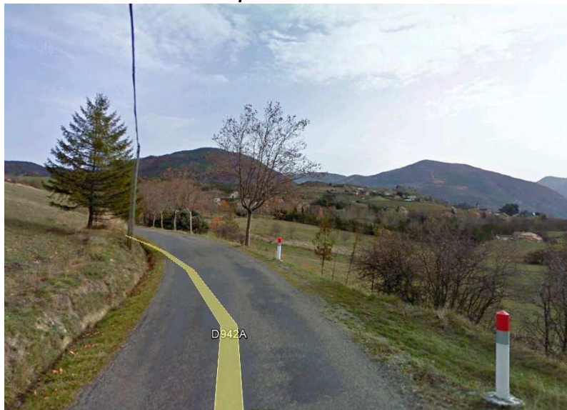
Vue depuis la RD 942a : 1
