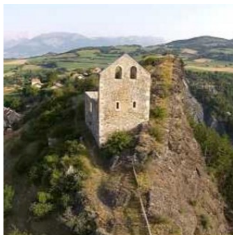
La tour de Jarjayes, ancien cloché
