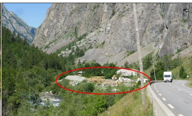
Zone NC, le stockage de matériaux est déjà existant
