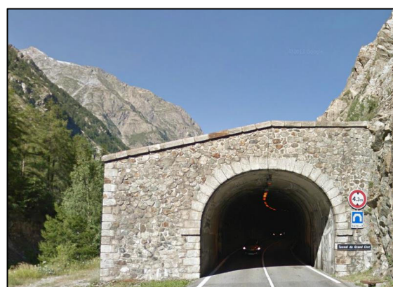
Tunnel du Grand Clot long de 670 m
