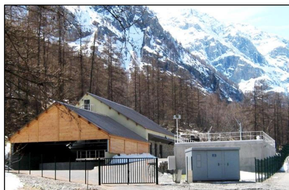
Station d'épuration du Pays de la Meije
