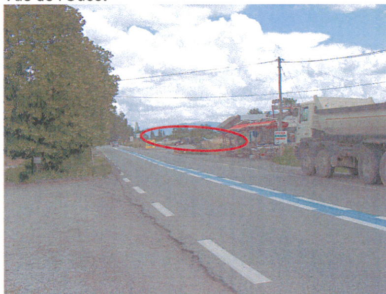
Vue de l'Ouest
