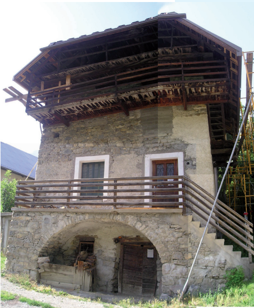
Freissinières : voûte d'entrée de l'étable soutenant l'escalier d'accès au logis.
