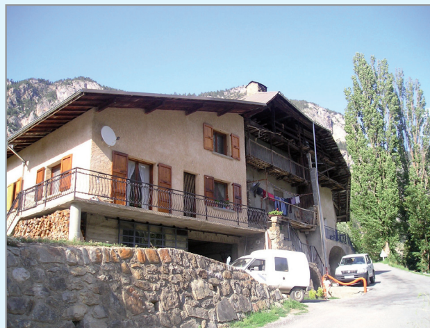
Freissinières : extension d'une maison traditionnelle avec des ouvertures plus larges et un balcon en structure bétonnée.
