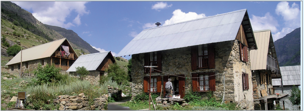
La pente détermine l'orientation des faîtages ; les hameaux (ici les Romans) présentent une forte cohésion dans l'organisation des constructions.
