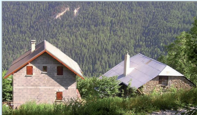
Maisons Neuves : volume plus haut que large, contrastant avec la construction ancienne voisine plus aplatie dans la pente.
