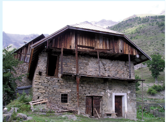
Dormillouse : bâtisse traditionnelle avec mantelage de planche sur la grange et balcon léger en saillie.
