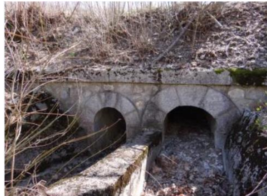
Canal de fuite sous la voie ferrée
