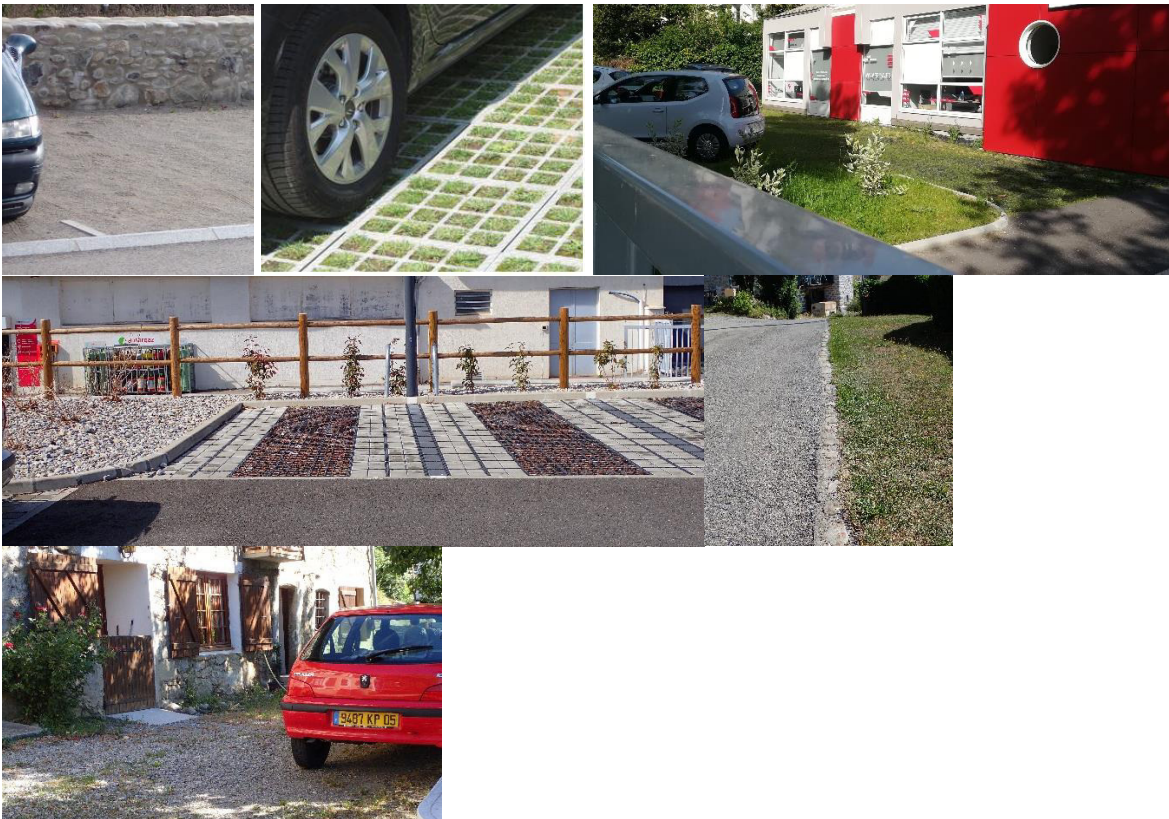
Exemple d'emploi de revêtements perméables pour tout ou partie des aires de circulation et de stationnement.
