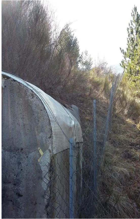
photo 1 : captage de Verdun vue extérieure
