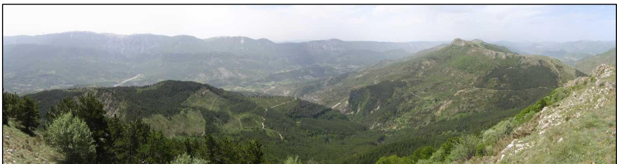
DEPUIS LA CRETE DE L'ANE VERS LE JABRON (SOURCE INTERNET : A. DUFOUR)
