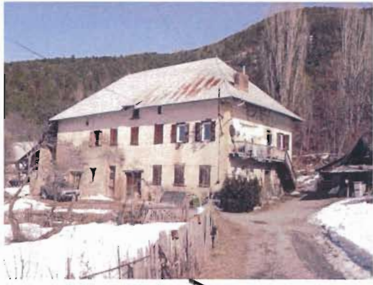
Maison hameau de Marquisard
