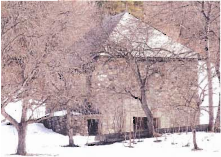
Maison hameau de Marquisard
