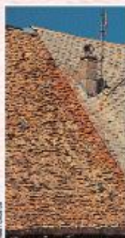
Toitures à Ancelle
