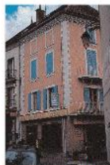
Traitement de façade en angle de rue
