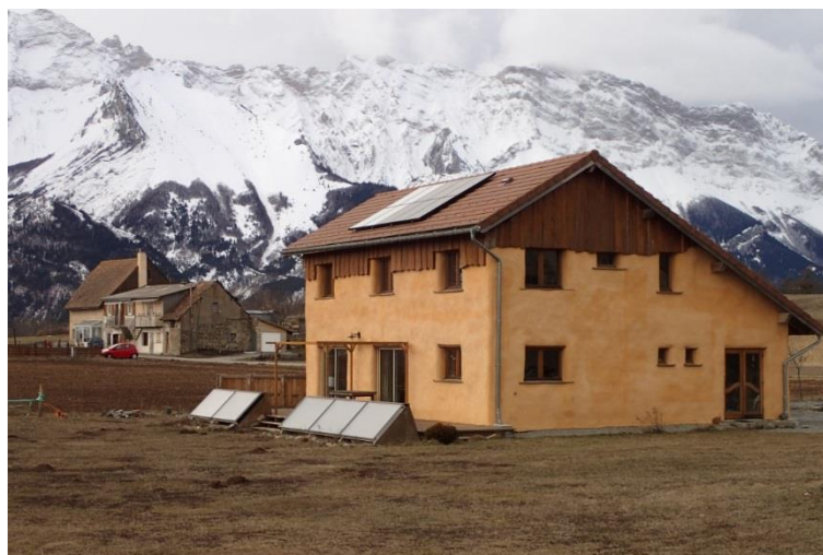
Installation de panneaux solaires sur une construction récente à Saint Eusèbe
