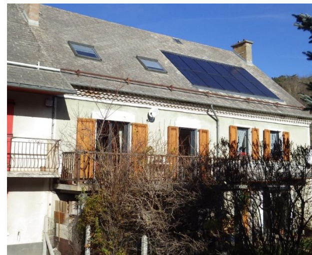
Installation de panneaux solaires dans le cadre d'une réhabilitation à Chauffayer
