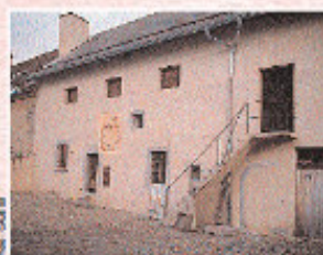
Réhabilitation dans le Champsaur
