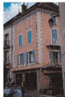
Traitement de façade en angle de rue
