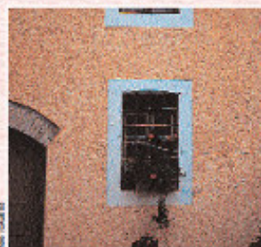
Réhabilitation de façade
