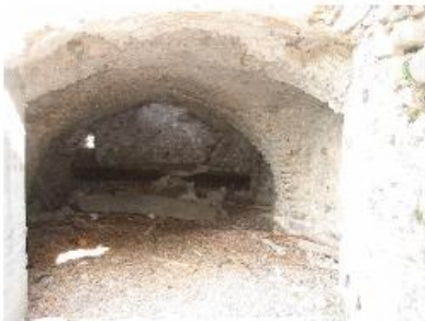
Bâti encore en attente de restauration
