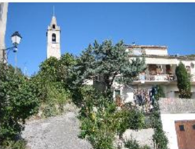
Travaux de restauration peu respectueux du patrimoine
