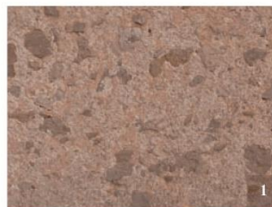
1. Enduit jeté et recoupé à pierres vues (La-Palud-sur-Verdon)
