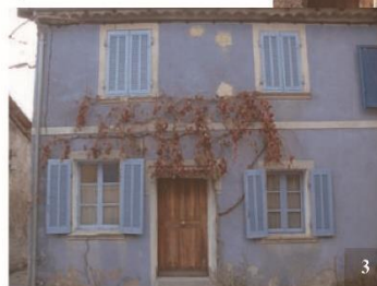
3. Enduit à la tyrolienne au mortier à gros grain teinté à l'oxyde métallique (Allons)
