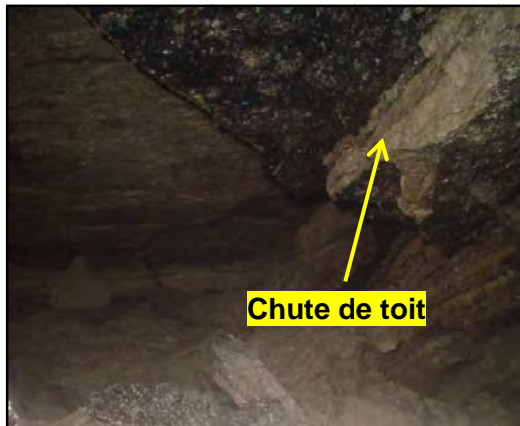
Figure 9 : Exemples de chutes de toit observées au droit du secteur Centre Sigonce
