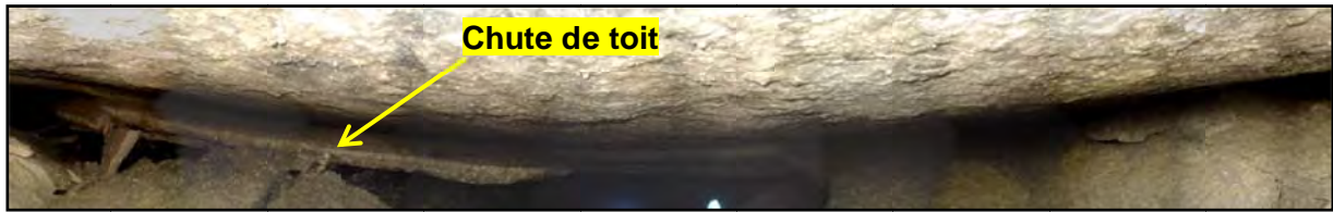
Figure 8 : Panorama 360° d'un des vides auscultés au droit du secteur du Lan
