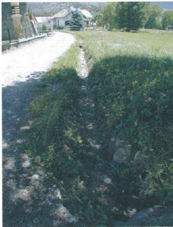
des fossés avec ou sans calades d'écoulement des eaux de pluie et d'arrosage
