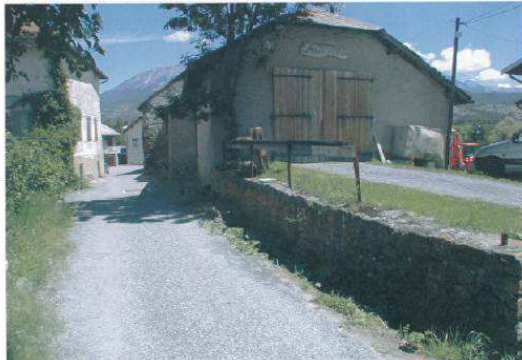
marquage de la différence de niveau et de la limite par un muret d'accompagnement en pierres et un caniveau EP
