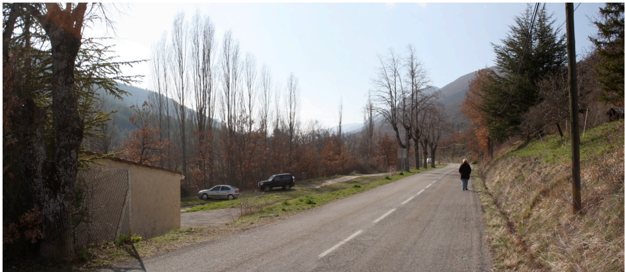
Vue du site depuis l'Est
