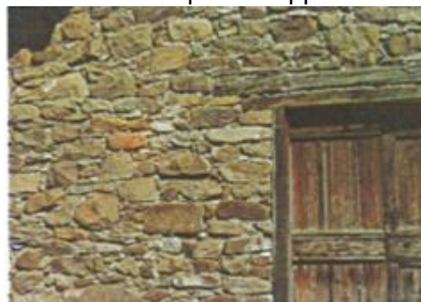
Parement en pierres apparentes
