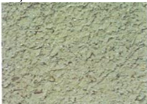
Enduit jeté au mortier de chaux naturelle
