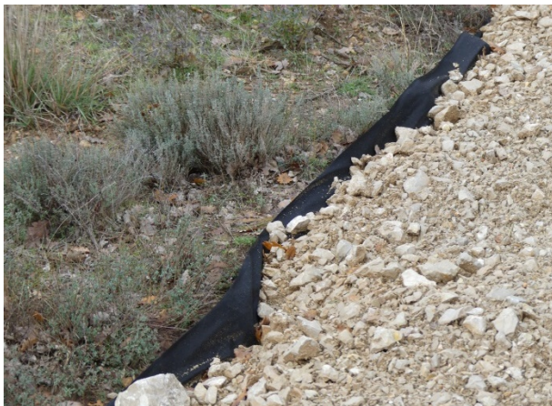
Géotextile placé sous une surface empierrée temporairement DRYOPTERIS, 2017
