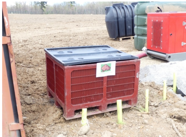
Stockage des terres et gravats pollués avant envoi vers un centre de traitement. DRYOPTERIS, 2017
