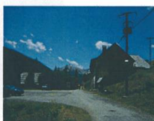
L'aménagement d'un parking d'accueil à l'entrée du hameau semble avoir limité les effets du stationnement dans le village. Toutefois, les espaces publics sont à requalifier (grande aire de stationnement en enrobé, réseaux aériens,...)
