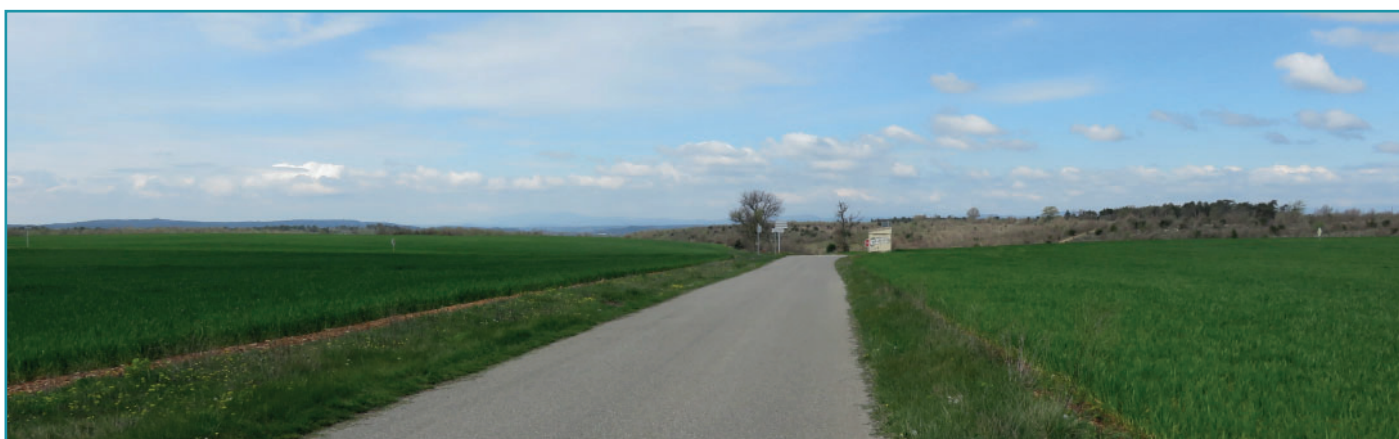
Vue vers le nord depuis la RD 311
