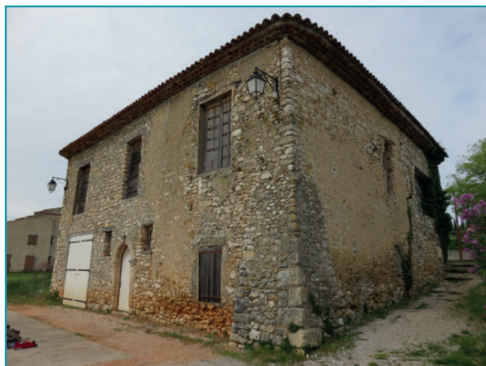
La propriété communale en cours de réhabilitation
