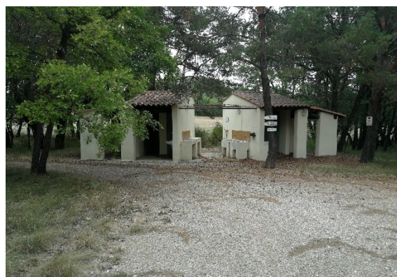
Repérage des bâtiments dédiés aux sanitaires
