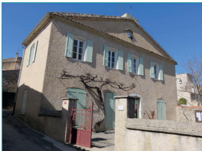
La mairie rue de la Fontaine
