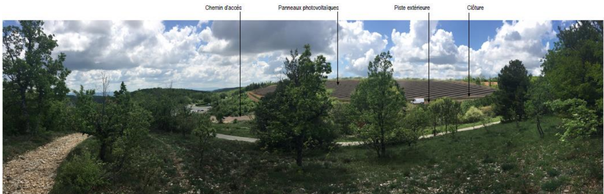
Mise en place des panneaux solaires
