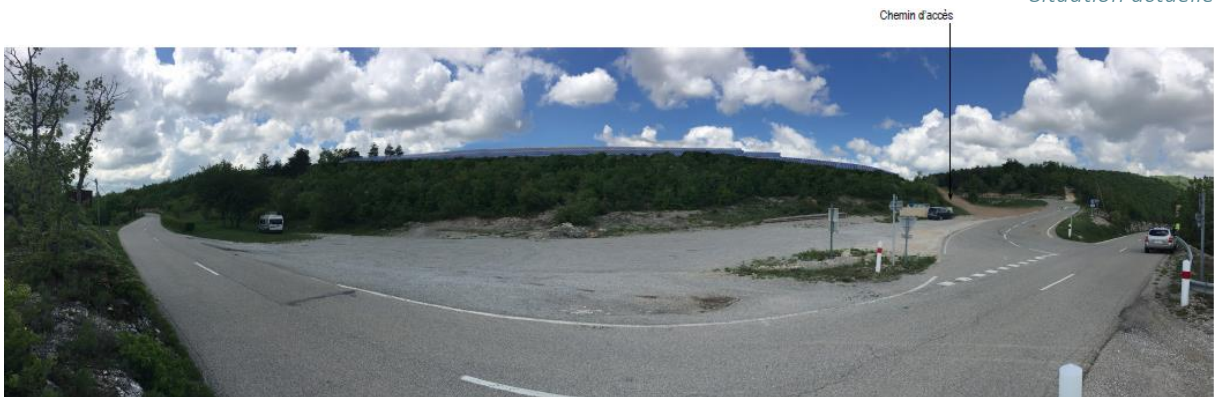
Mise en place des panneaux solaires
