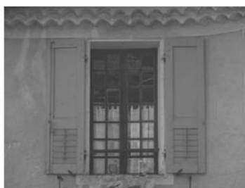
Fenêtre à petits bois et petits carreaux (Moustiers-Sainte-Marie)
