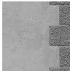
Décor de chaîne latérale harpée enduite à la tyrolienne à finition grenue formant un fort contraste de teinte et de texture (Montagnac-Montipezat)
