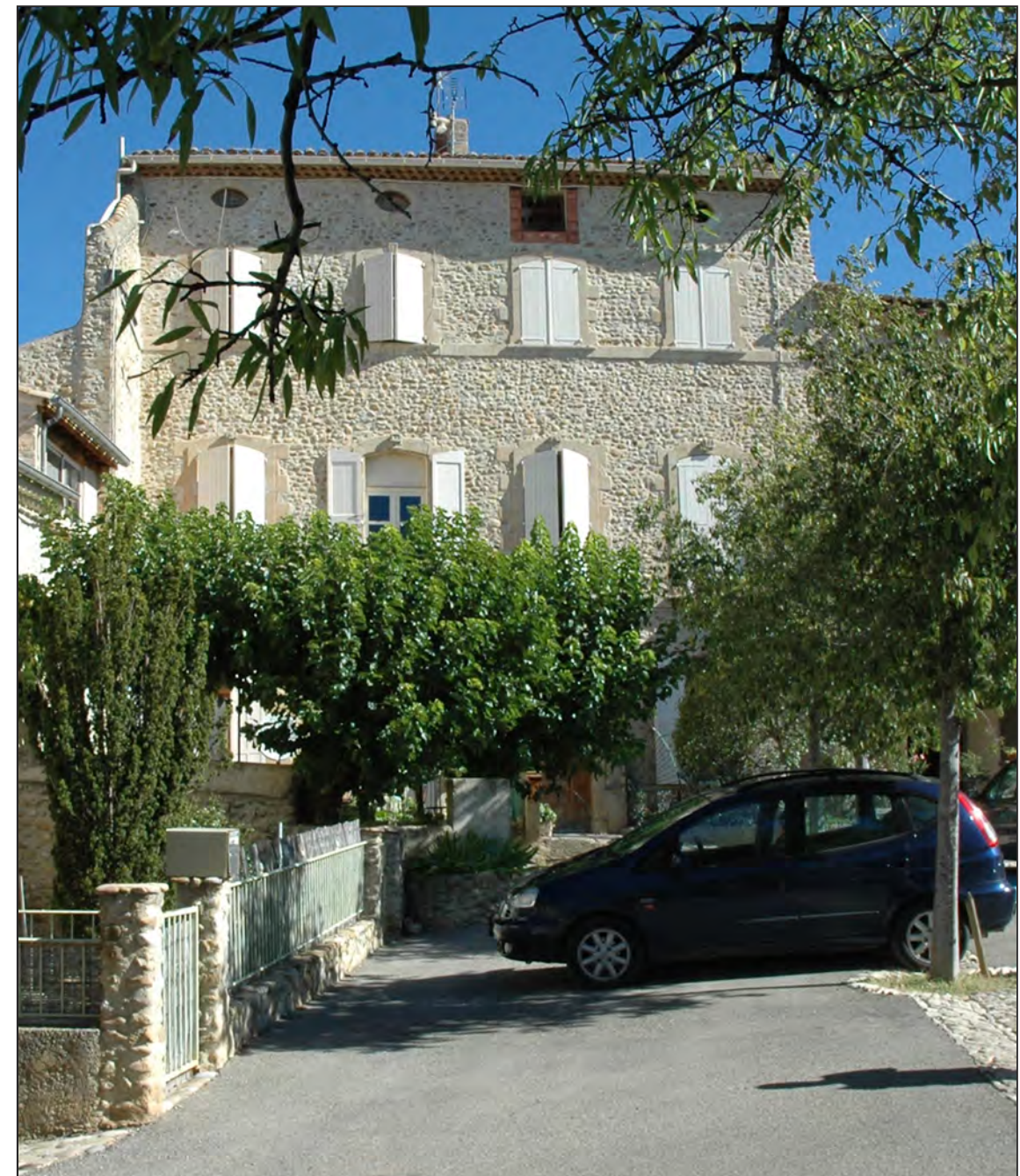
Exemple de façade ordonnancée
