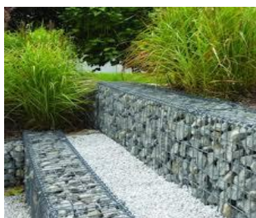
Soutènement en gabions plantés
