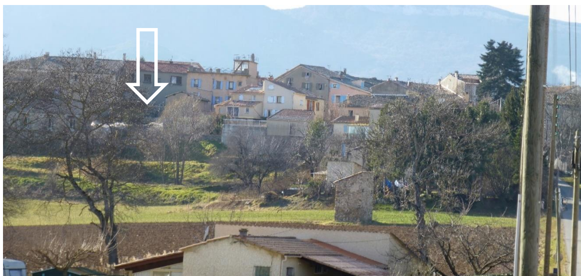
Aperçu de la façade Est du village des Armands
