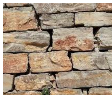
Enrochement de blocs calibrés et appareillés
