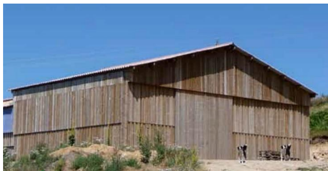
Exemples de bâtiments revêtus de bardages en bois (lames verticales ou clins) avec ou sans soubassement maçonné.
