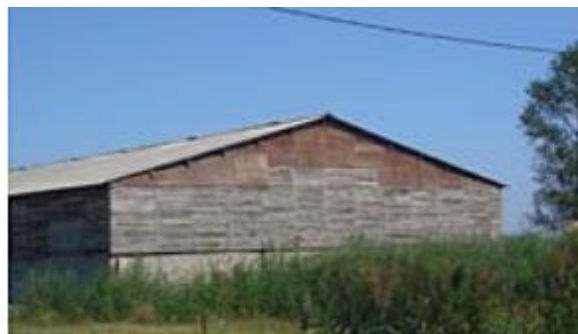
Exemples de bâtiments revêtus de bardages en bois (lames verticales ou clins) avec ou sans soubassement maçonné.
