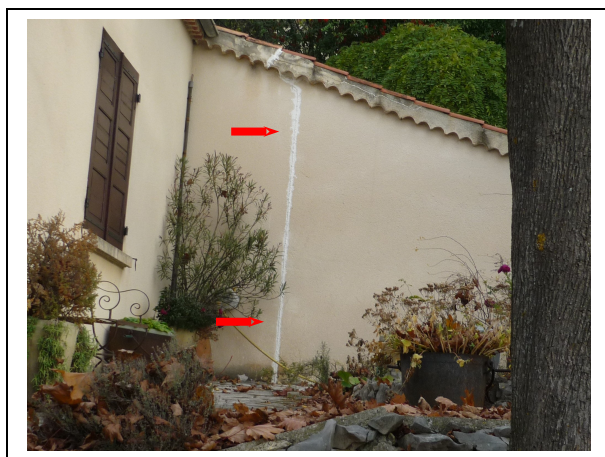
Figure 13 : Fissures et travaux de confortement sur des maisons (Quartier de la Condamine) [Source : IMS RN ]
