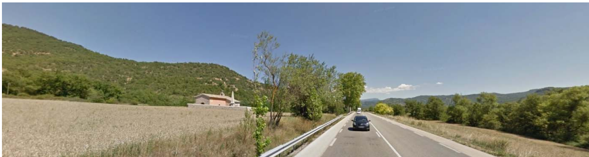
PHOTO : VUE SUR LA ZONE D'ACTIVITE COTE MALIJAI DEPUIS LA RN 85 (SOURCE : STREET VIEW)
