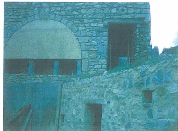
Figure 23 : réhabilitation d'une grange en bâtiment d'habitation
