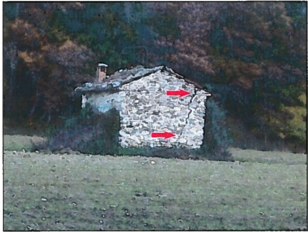
Figure 15 : Fissures sur des constructions (secteur de la Laye) [Source : IMS RN ]
