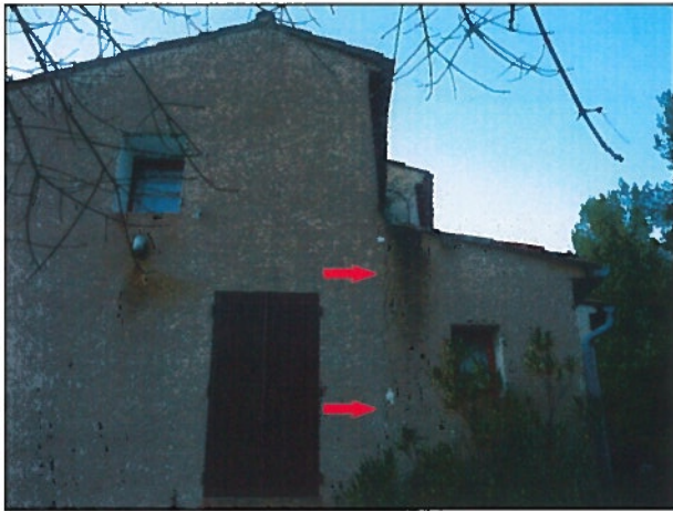
Figure 15 : Fissures sur des constructions (secteur de la Laye) [Source : IMS RN ]
