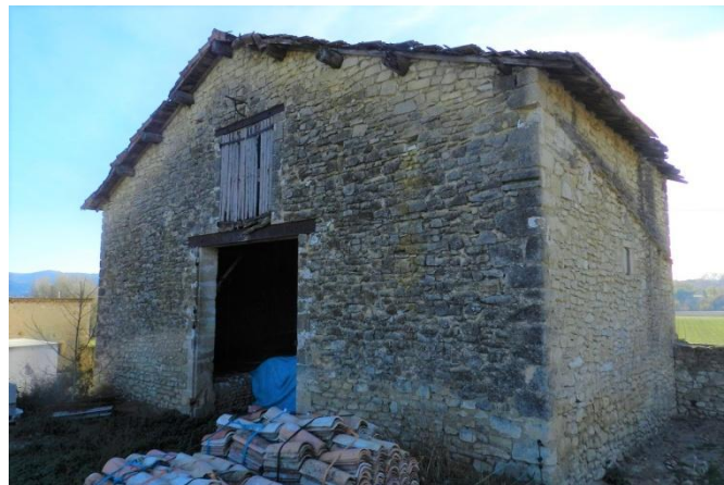
Côté nord-ouest (niveau +1)
