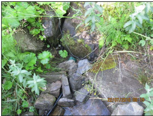
Captage du Villard
