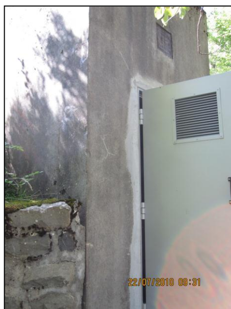
Réservoir des Gourets
