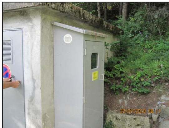
Captage récent du Lauzet
